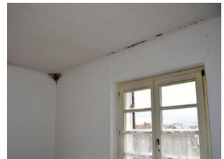
*Hohe Luftfeuchtigkeit führt zu Kondensat in den Raumecken und somit zu Schimmel*
